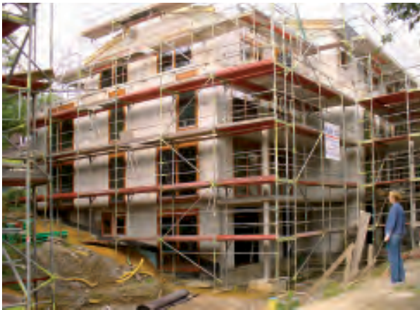
Baustelle Südring 23, Hattingen, Projekt „wir wohnen zusammen e. V. / hwg eG Foto: Rolf Novy-Huy
