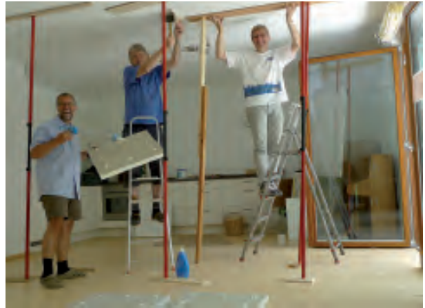
Südring 23: Innenausbau Isolierarbeiten
