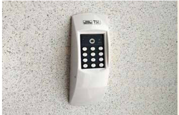
Elektronisches Schließsystem: Pincode-Tastatur
